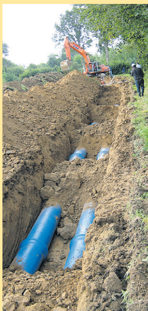
Mise en place de canalisations d'eau potable par le syndicat d'eau Baie Bocage.
