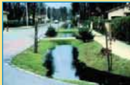
Une noue en bordure de lotissement
