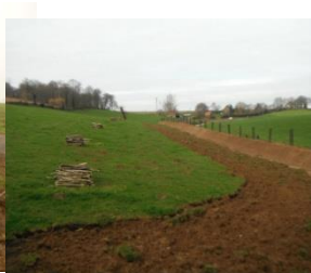
Conduite de travaux
