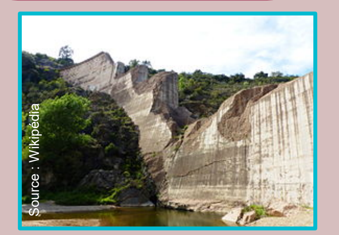
Ruines du barrage de Malpasset
