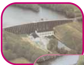
Barrage de Vezins, EDF
