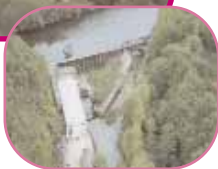
Barrage de LROB, EDF
